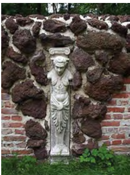
شکل (۶) دیوار با هرمایی - استفاده از سنگ معدن باتلاق در معماری
